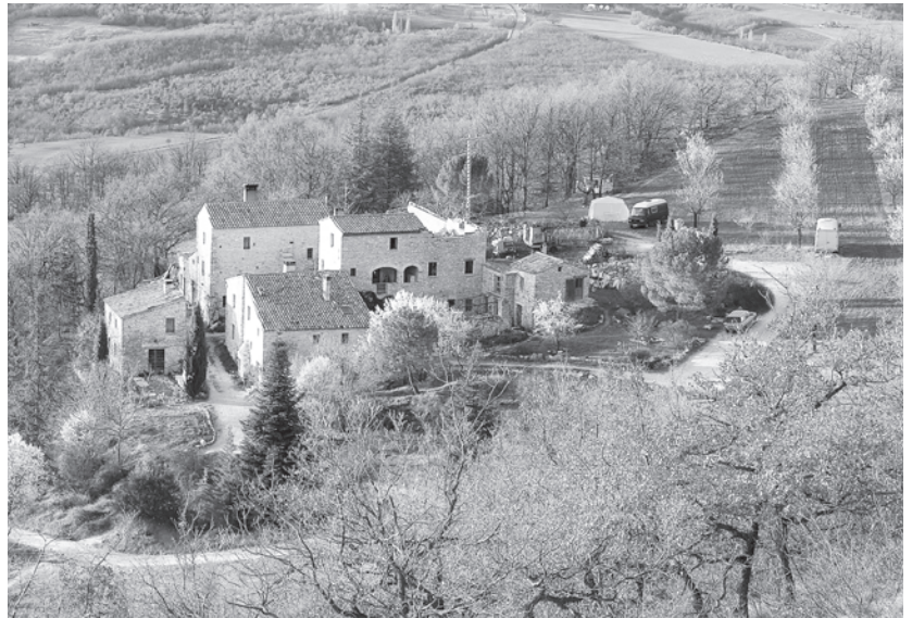
Hippolyte im Aufbau. Die linke Seite ist bereits bewohnbar. Wir wollen nun das letzte grosse Gebäude hinten rechts fertigstellen.
