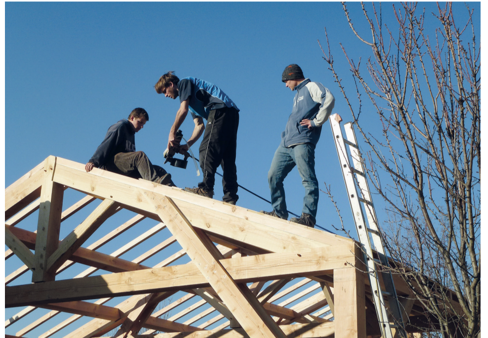
Dachstuhl und Fachwerk für das Textilatelier auf der Kooperative in Limans werden errichtet.
