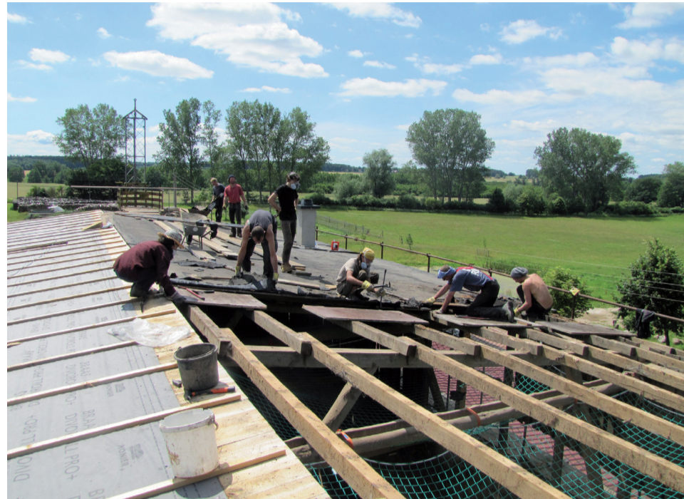
Das Leben ist eine Baustelle: Das alte Scheunendach auf dem Ulenkrug wird ausgewechselt.
